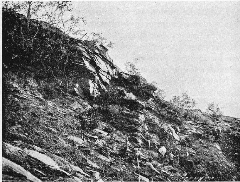
Piquetage au km. 2.100
