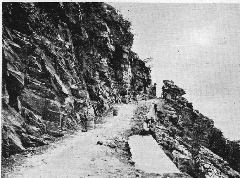
La plate-forme au km. 2.700
