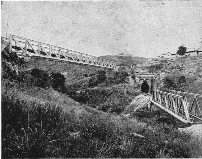
Matadi — Tunnel et Pont du Ravin Léopold
