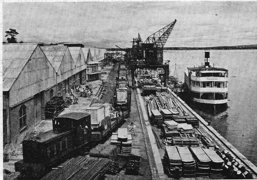
Installations de la « Citas » à Léopoldville
