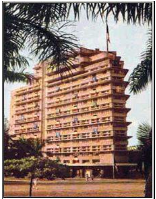
Le building Forescom, premier building construit en 1949 à Léopoldville. © Collection Hvz.
