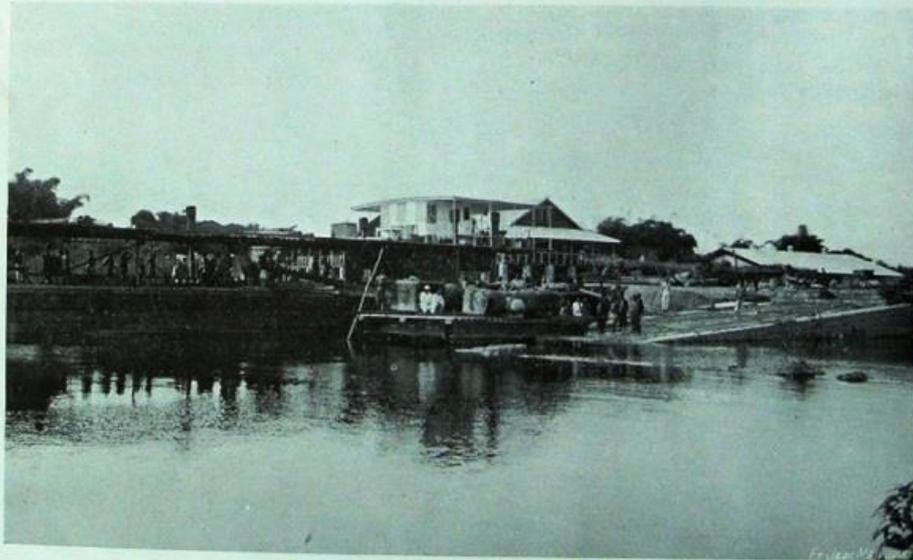
Fig. 52. — Le même transbordeur accolé à un vapeur se rendant à Stanleyville. La chaudière sera glissée sur le pont du steamer.
