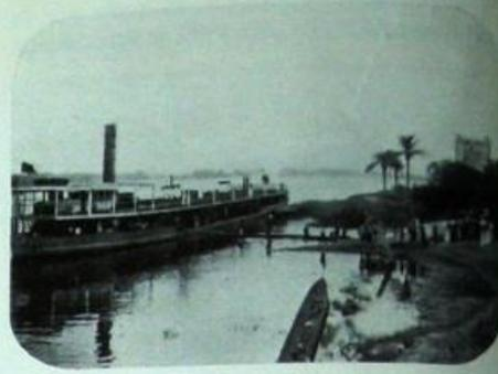
Fig. 47. — Le *Segetini*. Quand un vapeur accoste à la rive d'une station, il est ancré à l'avant et réuni à la terre par des câbles. Une double et solide planche relie le premier pont à la rive.
