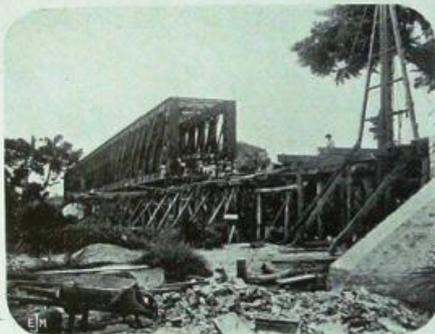
Fig. 38. — Le montage du pont de l'Inkisi.
